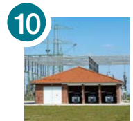
10 Relais- und Betriebsgebäude
