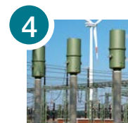
4 Strom- und Spannungswandler
